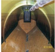
In einem Mehrfamilienhaus wurde ein Öl-Erdtank mit einem Volumen von 50.000 Litern zu einem Pelletlager umgebaut.
