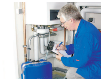
Befüllung mit richtigem Heizungswasser
